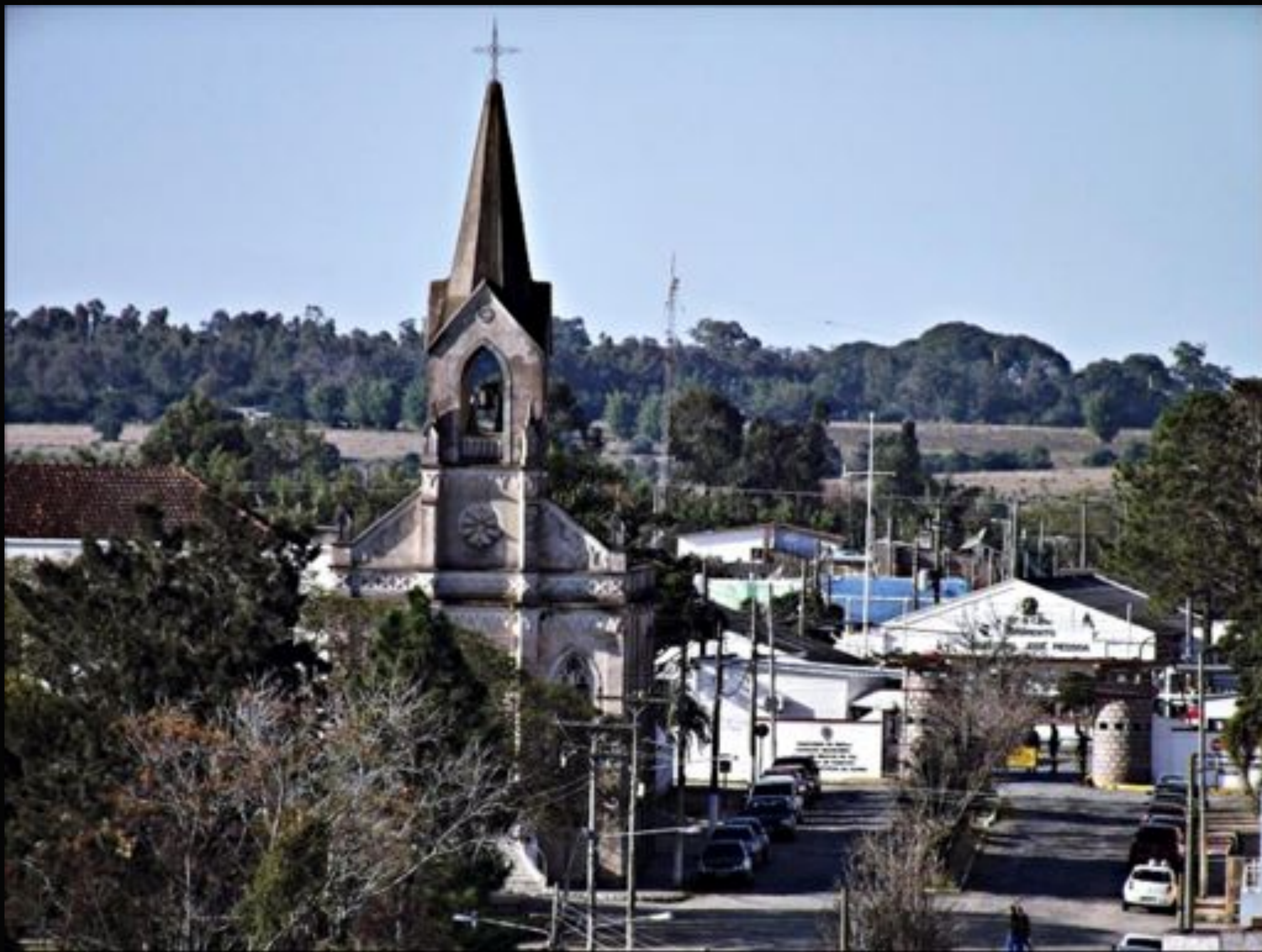
Fonte: Igreja da Santa Casa de Caridade.
